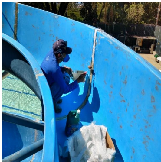
Foto 17: Aplicação da fibra de vidro.
