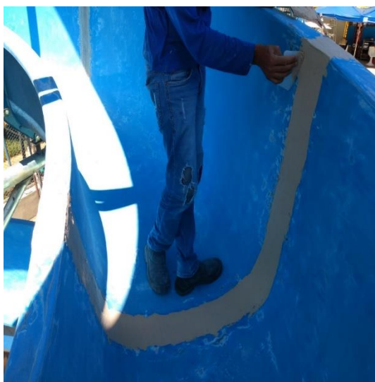
Foto 18: Aplicação da massa de poliéster.
